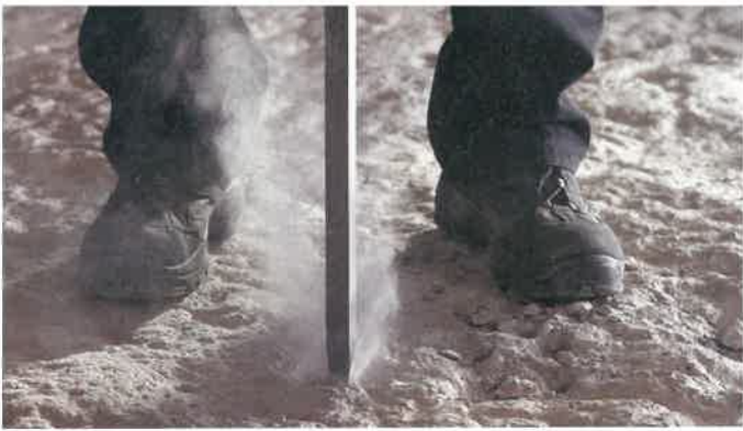
Abbrucharbeiten ohne Absaugung: Der aufgewirbelte Staub verbreitet sich. Bild: Duss
